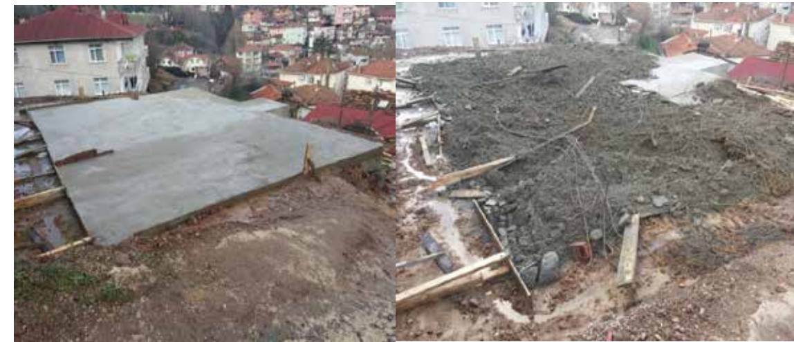
(Mahmut Şevket Paşa mahallesinde 775 sayılı yasanın 18. maddesine göre yapılan yıkıma ait görsel)
