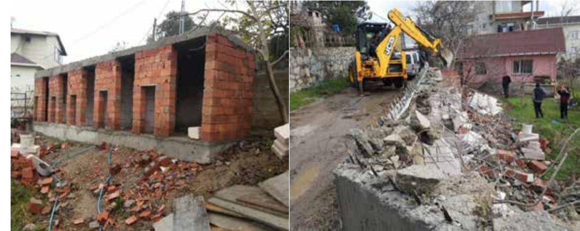
(Riva mahallesinde 775 sayılı yasanın 18. maddesine göre yapılan yıkıma ait görsel)
