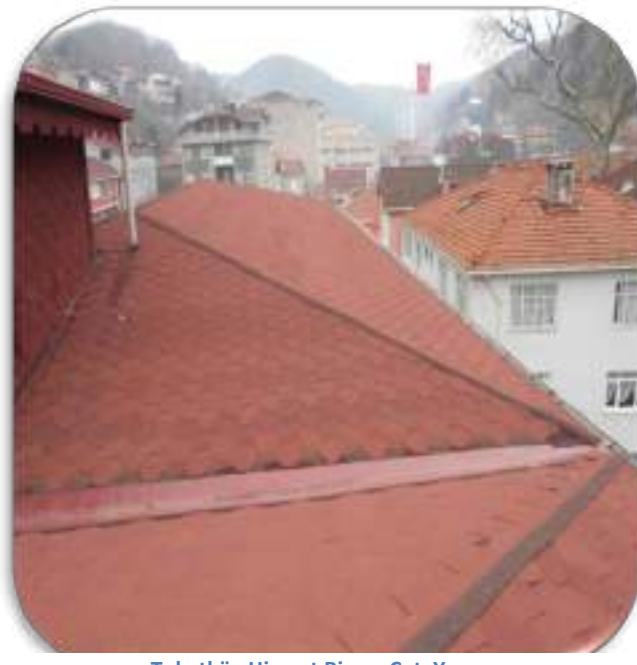
Tokatköy Hizmet Binası Çatı Yapımı
