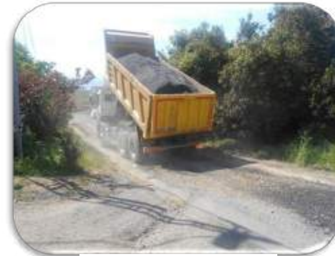
Riva Mahallesi Asfalt Kırığı Serimi
