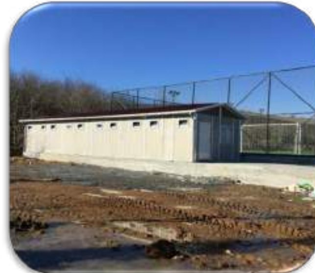
Ali Bahadır Halı Sahası Prefabrik Temel Yapımı
