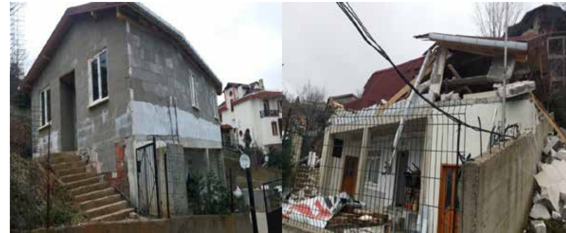
(Baklacı mahallesinde 775 sayılı yasanın 18. maddesine göre yapılan yıkıma ait görsel)
