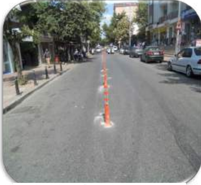
Kavacık Mahallesi Otağtepe Cad. Delinatör Uygulaması
